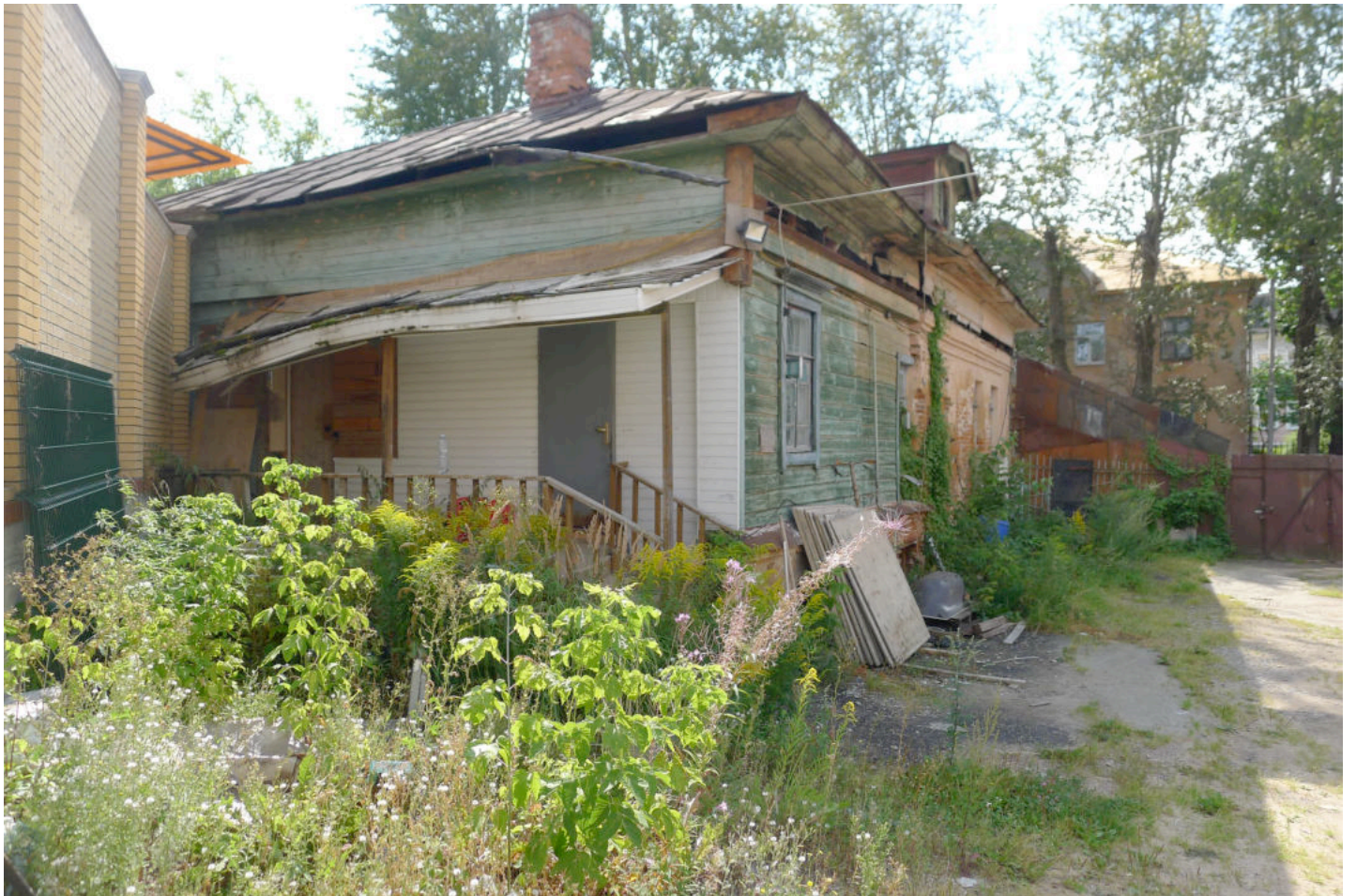
Фото 7. Вид с северо-запада.
