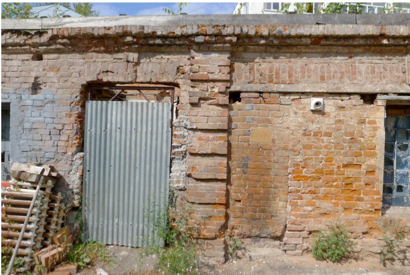
Фото 14. Фрагмент восточного фасада.
