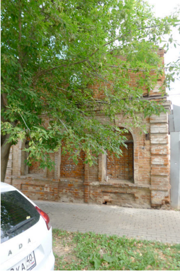
Фото 9. Конюшня. Уличный фасад.
